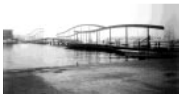
La construcción de la pasarela sobre las aguas del puerto, obra de H. Piñon y A. Viaplana, ha supuesto la solución de continuidad de las Ramblas hasta el mar.
