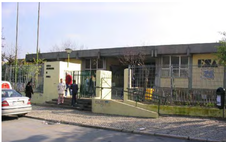
Figura 1: Escola Secundária da Amora – vista da entrada
