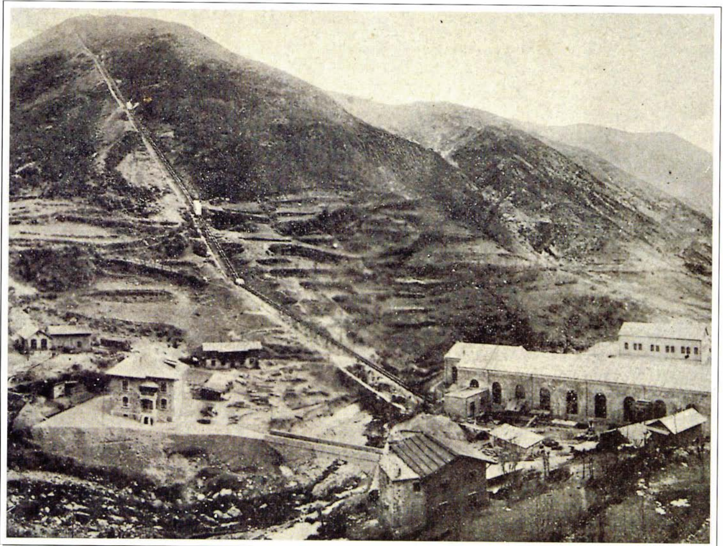
8.1 - La central hidráulica de Capdella inaugurada en 1914 fue una de las más modernas instalaciones de Europa en su época. En la fotografía se aprecia con claridad la tubería forzada que salva un desnivel de 800 m conectando la región lacustre de Estany Gento, a más de 2.000 m, con dicha central.
