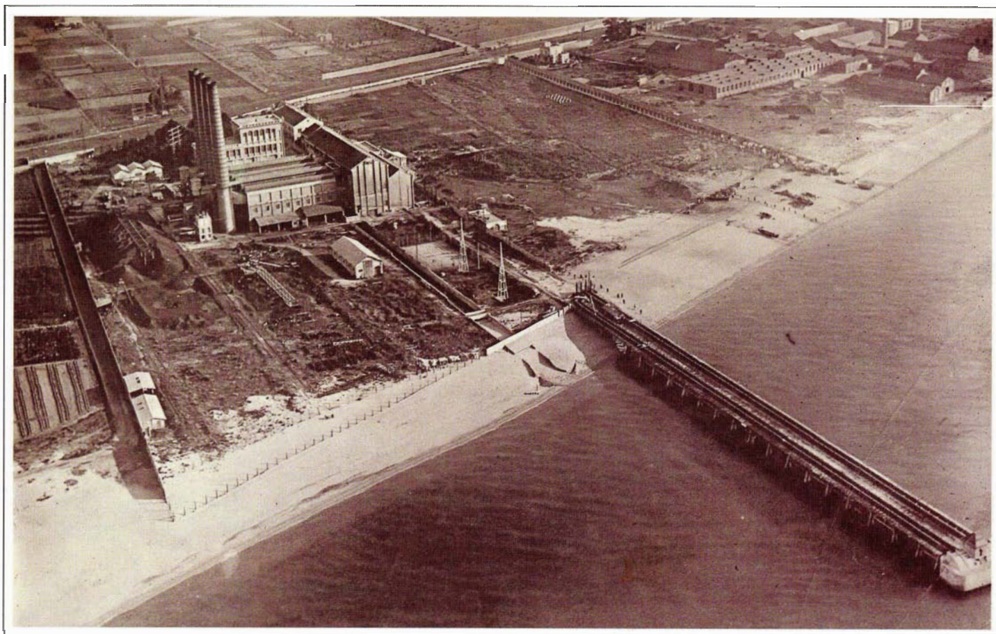
8.6 - Vista general de la central térmica de Sant Adrià del Besós de EEC. En primer término se puede observar la estacada, que recogía el agua del mar para refrigerar las calderas. En la parte izquierda de la foto aparecen depósitos de carbón. Al lado mismo de éstos puede apreciarse una línea de ferrocarril.
