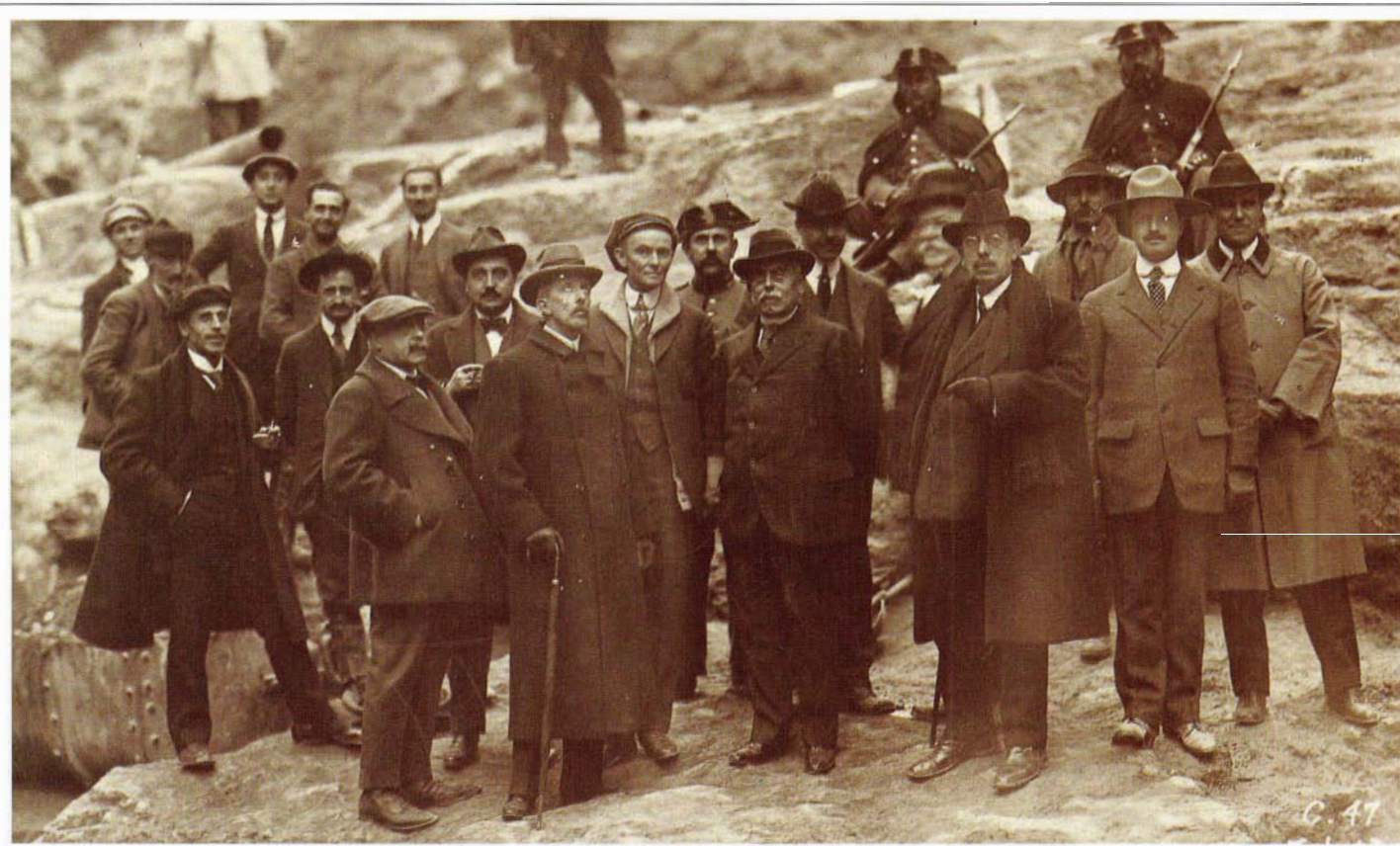
9.3 - Visita de directivos de la empresa a las obras de Camarasa el 13 de febrero de 1919, días antes de que estallara la huelga general. La protección de la Guardia Civil refleja la tensión social que se vivía.
