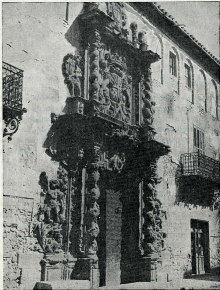
Fachada principal del palacio de Guevara, de 1694.
