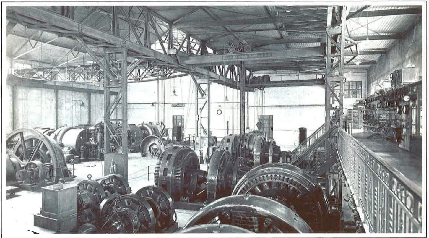
2.18 - Sala de máquinas de la central térmica de Muta, tras las ampliaciones de los dos primeros decenios. Fotografía tomada el 11 de junio de 1927. En el puente grúa se distingue claramente el nombre del constructor alemán Ludwig Stuckenholz, Wetter u. d. Ruhr.
