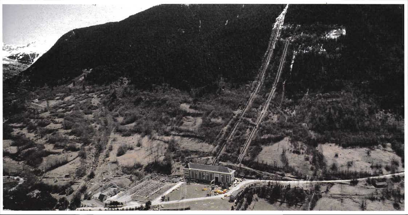
12.11 - Central Hidroeléctrica de Bossost, en el valle de Aran.
