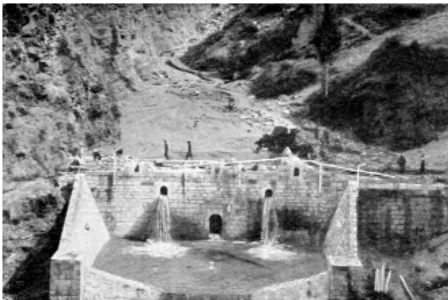
Figura 195 Impedir los desbordamientos del Segre exigía retrasar las avenidas mediante obras en su cuenca que corrigieran las pendientes por las que descendían con rapidez sus aguas. Para ello se construían diques como el que aparece en la fotografía perteneciente al torrente Enseu.
