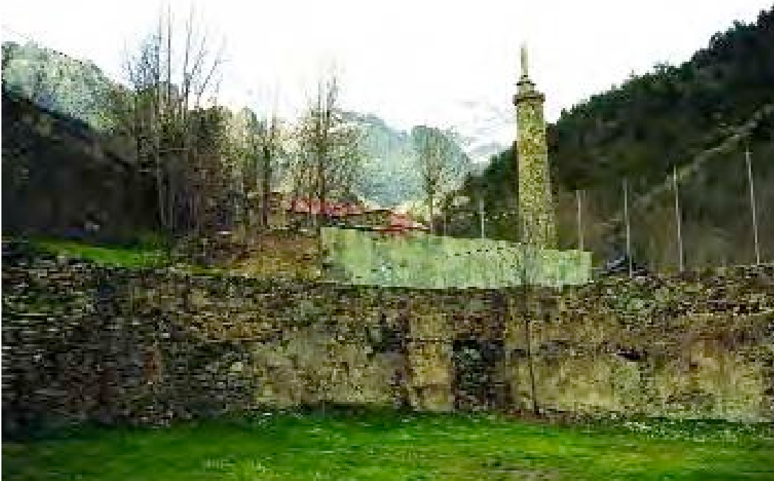
Figura 110 Restos de los muros de la antigua farga de Queralbs, que aprovechaba los abundantes recursos forestales e hidráulicos del lugar. Con el tiempo, el destino de las instalaciones ha sido diverso, pues fue también central hidroeléctrica durante un tiempo, y en la actualidad sobre sus restos están ubicadas las instalaciones recreativas de una orden religiosa.
