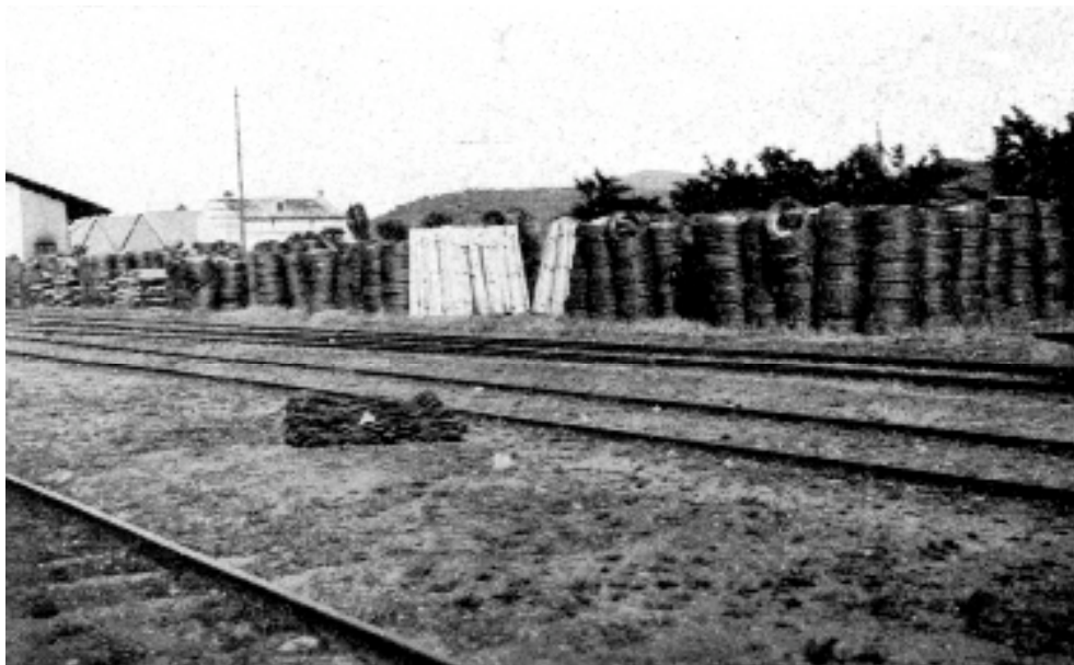
Figura 178 Estación de ferrocarril de Breda a mediados del siglo XX, una de las existentes en el Montseny en la que se efectuaba la salida de los productos forestales de la zona. Allí esperaban paquetes de aros, vigas y serones de carbón, indicando una actividad importante de la industria forestal en esta parte de Cataluña.
