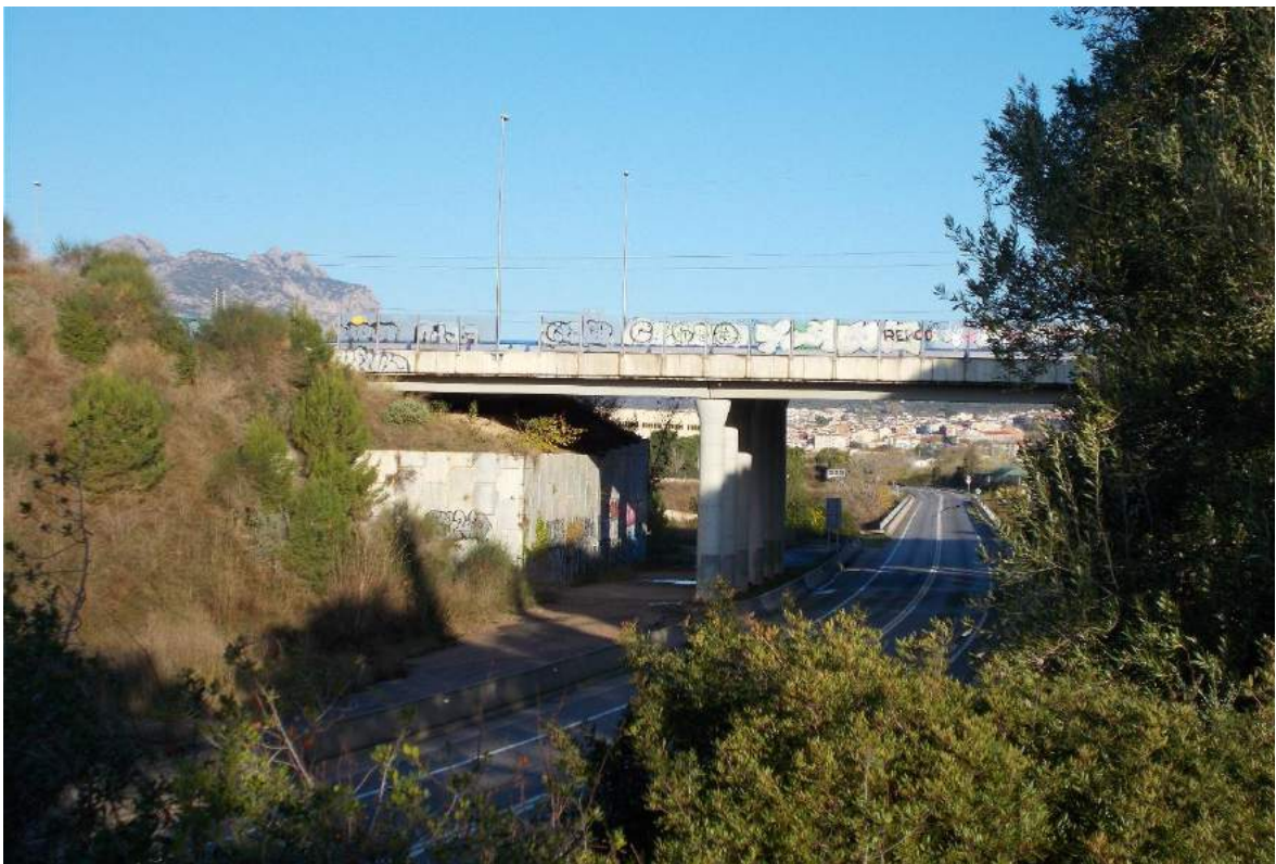
Figura 1. Parte de la fragmentación de hábitats es producida por infraestructuras viarias, como carreteras y autopistas. Con frecuencia, los puentes grandes y muy elevados (arriba) confieren una mayor permeabilidad estructural y funcional que los puentes pequeños con taludes largos situados en ambos extremos (abajo). Municipio de Abrera, Catalunya (Fotos: Juan Carlos Guix).
