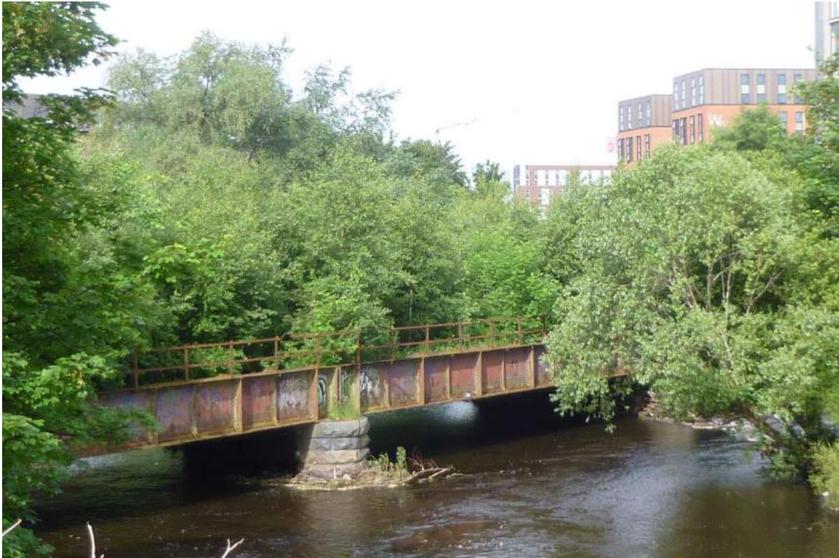
Figura 5. Puente abandonado de una vía férrea sobre el río Kelvin, en la ciudad de Glasgow, Escocia. La vegetación espontánea que ha colonizado este puente facilita su función como ecoviaducto (Foto: Proyecto Neopangea).
