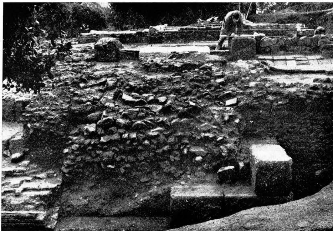
Sillares de granito en la infraestructura del edificio y en el zócalo de los muros
