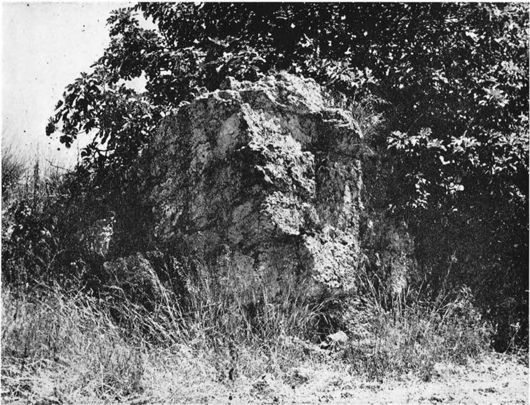
4. Tejada. — Torre despojada de su sillería
