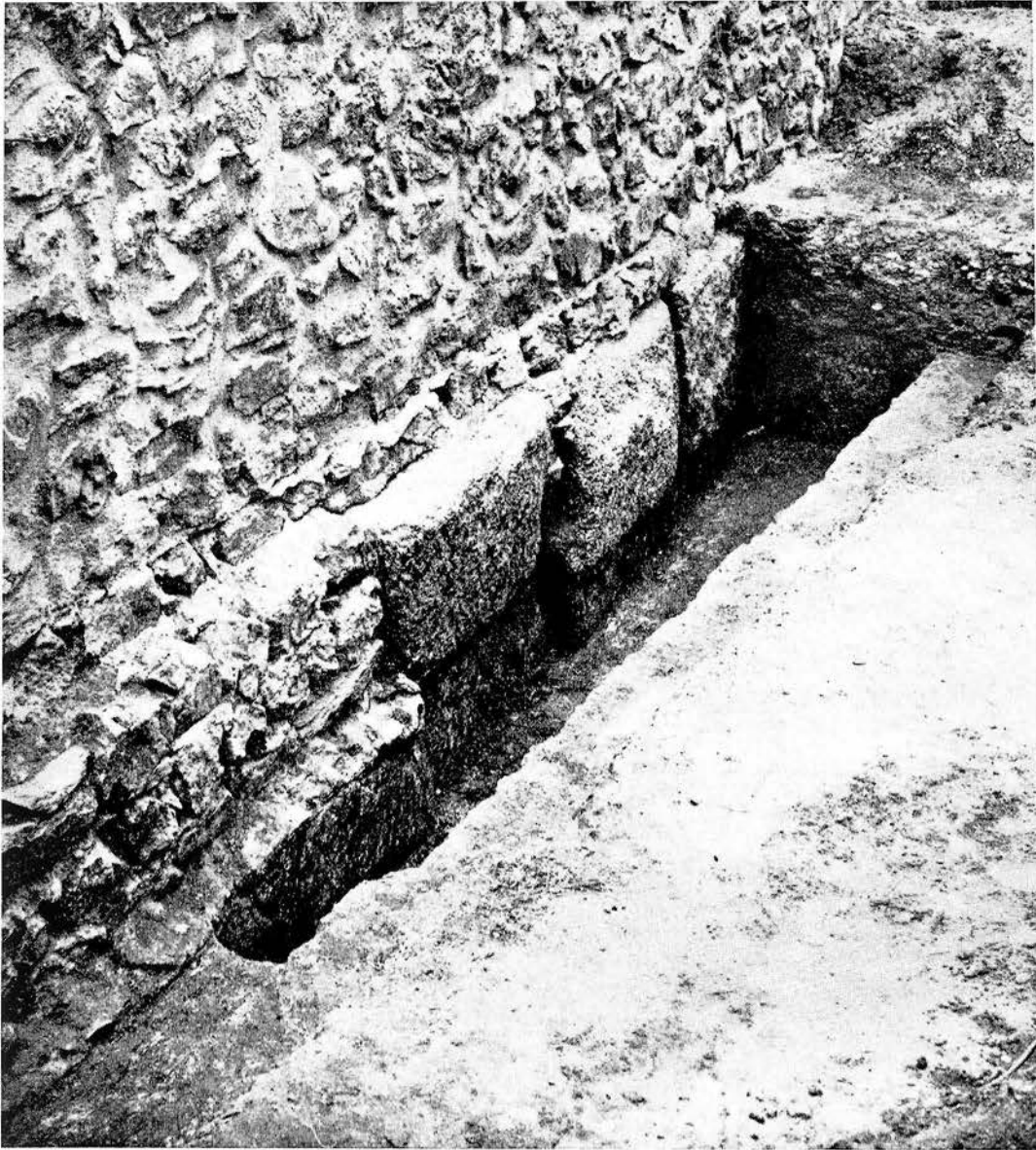
Acueducto de Segovia. — Excavación arqueológica realizada junto a la torre segunda. Restos de un pilar romano, tras cuya destrucción se construyó un muro corrido para soporte del canal
