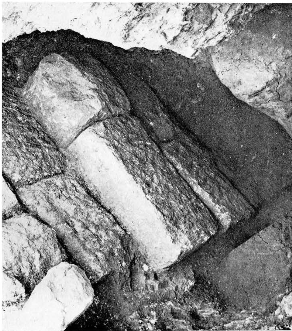
Acueducto de Segovia. — Corralillo de San Sebastián. Fosa y cimiento de uno de los pilares romanos aparecidos durante nuestros trabajos
