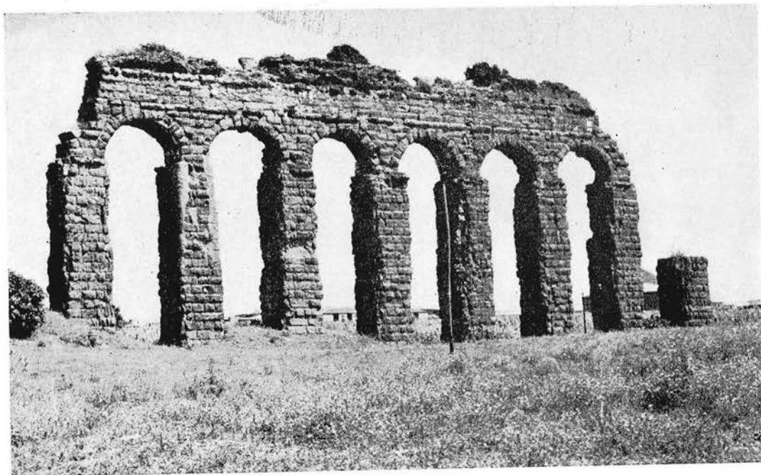
FIG. 44. — Tramo del Agua Claudia.
