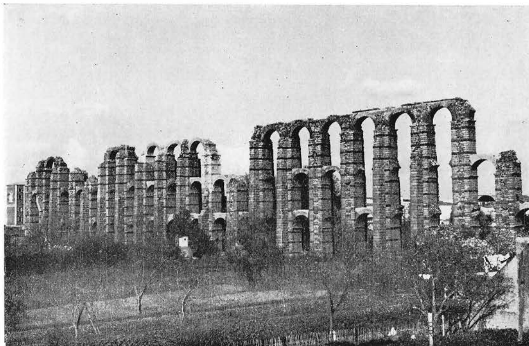
6. Acueducto de «Los Milagros». Obsérvese en la parte central de los pilares, las recientes restauraciones
