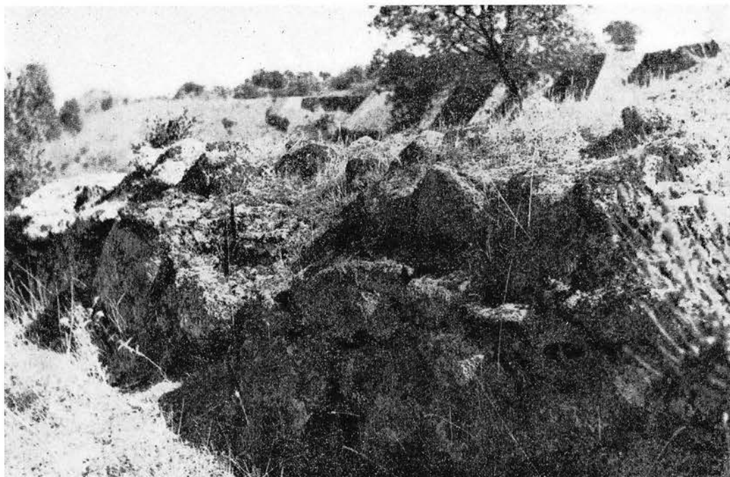
1. Detalle de la canalización del Arroyo de las Adelfas, que alimentaba el embalse de Proserpina. En primer término, los restos de la obra romana. Al fondo, la canalización moderna
