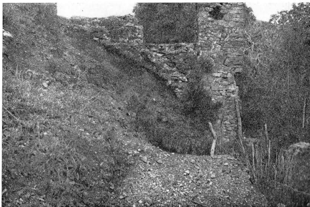
Vista del acueducto de «Arcos Quebrados» desde el sur
