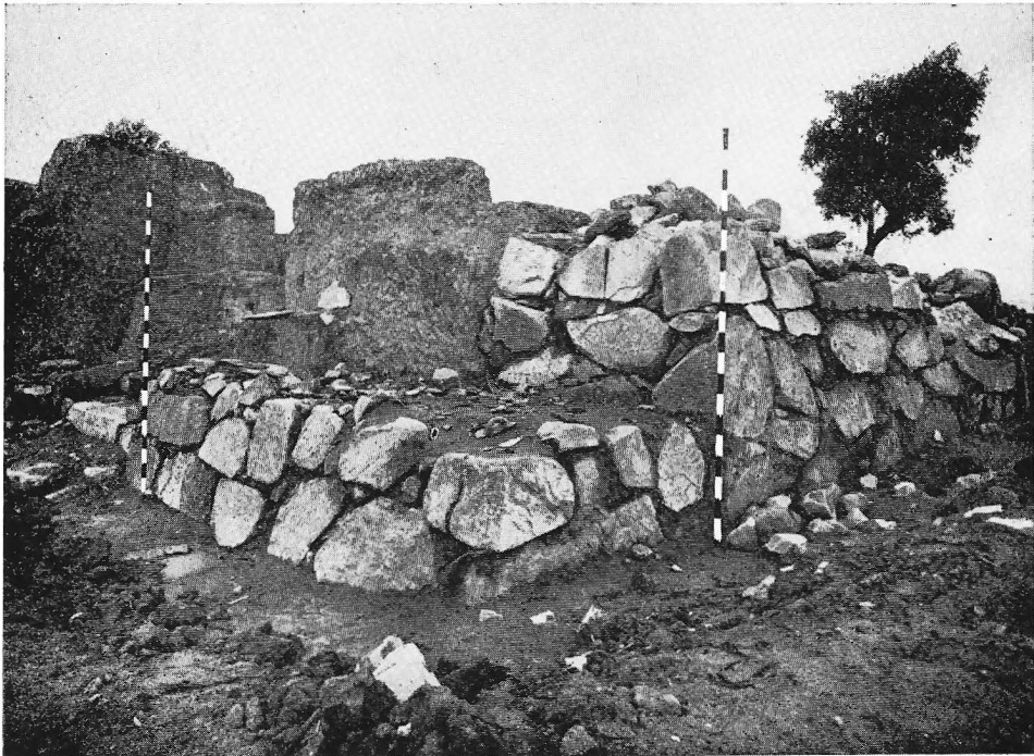
Banqueta del pati i parament del nord-est. Tercera campanya d'excavacions. Tardor de 1979.
